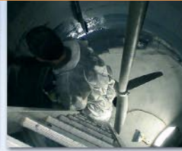
A teljes felület bevonásra került, részleges kikeményedés után egy második bevonóréteg is felvitelre került
